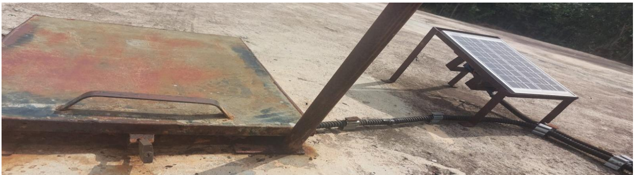
Figura 14 – Tampa do Reservatório de Água
