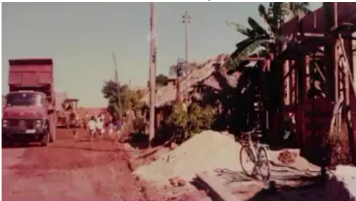
Figura: 5 e 6 Antes e Depois da Rua Bela Vista (última rua do bairro Alto da boa vista I)
