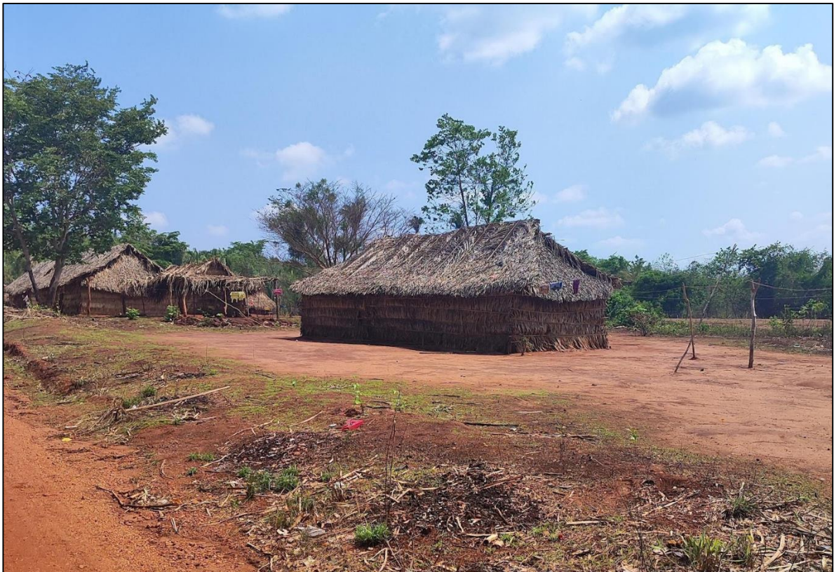
Figura 7 – Casa do Povo Apinajé feita com a palha do babaçu
