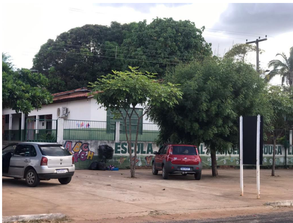
Figura 1 - Entrada da Escola Municipal Manoel de Sousa Lima.
