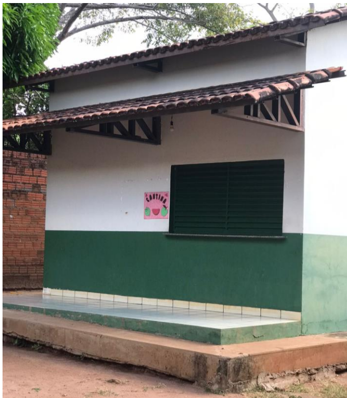
Figura 3 - Estrutura da cantina da escola
