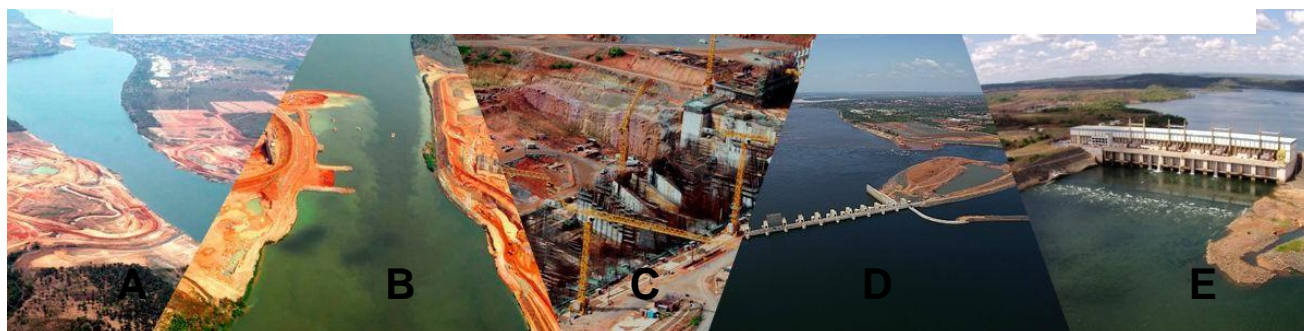
Figura 1 – Registros da construção e finalização da UHE
