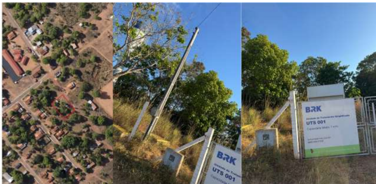
Figuras 8, 9 e 10 - Poço de fornecimento de água e iluminação pública
