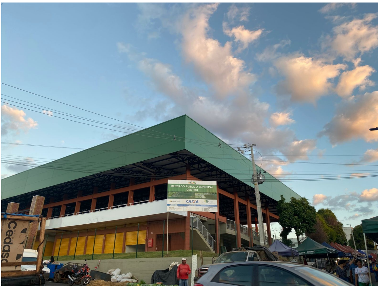
Figura 5: Mercado Municipal de Araguaína fachada atual
