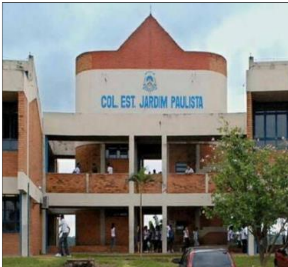
Figura 3. Fachada principal do Colégio Estadual Jardim Paulista
