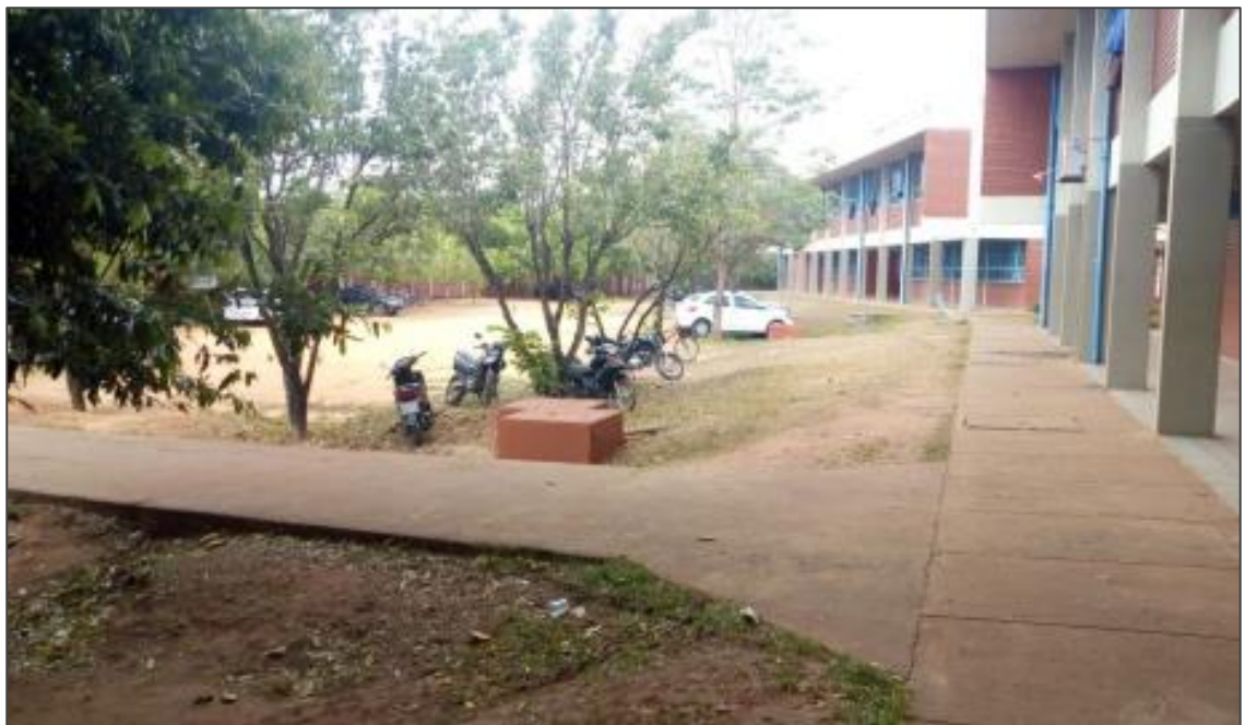
Figura 6. Rampa de acesso a entrada principal
