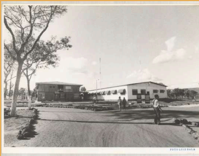
Sede provisória da Assembleia Legislativa do Estado do Tocantins em 1993 – Foto: Luiz Bala/Arquivo GEPAC/FCP
