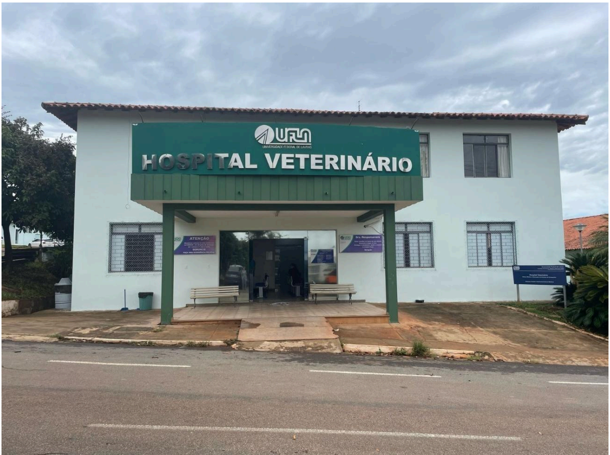
Figura 1. Fachada do Hospital Veterinário de Pequenos Animais da UFLA, em Lavras, Minas Gerais.
