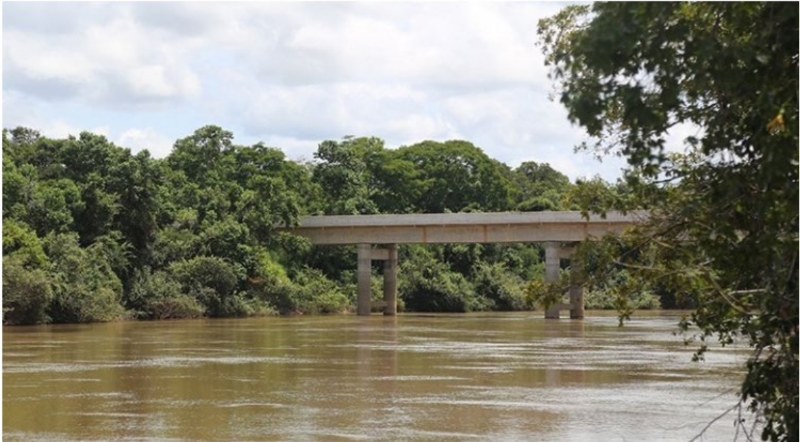
Figura 4: Ponte sobre o rio Manoel Alves
