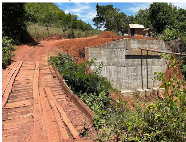
Figura 8 - Ponte velha de madeira; estrada de acesso ao povoado, onde estão construindo a ponte.
