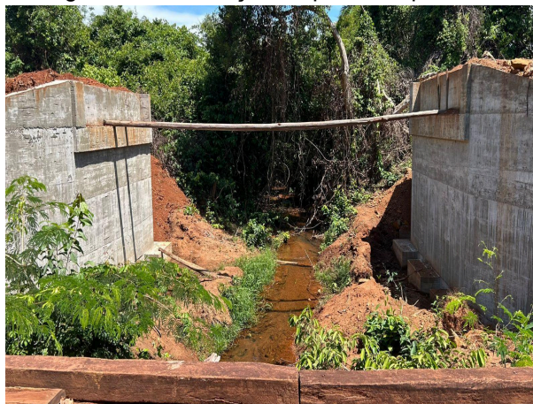
Figura 9 - Construção da ponte no povoado
