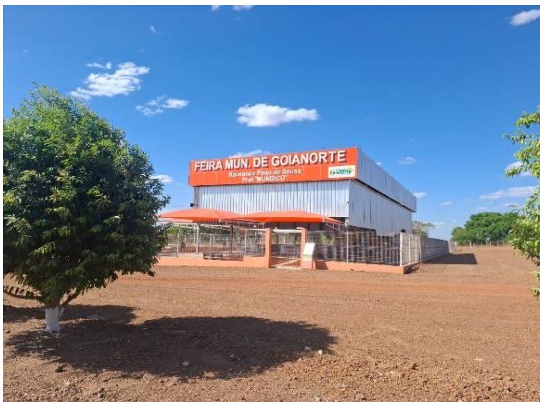
Figura 18 – Foto do prédio da Feira Municipal de Goianorte.
