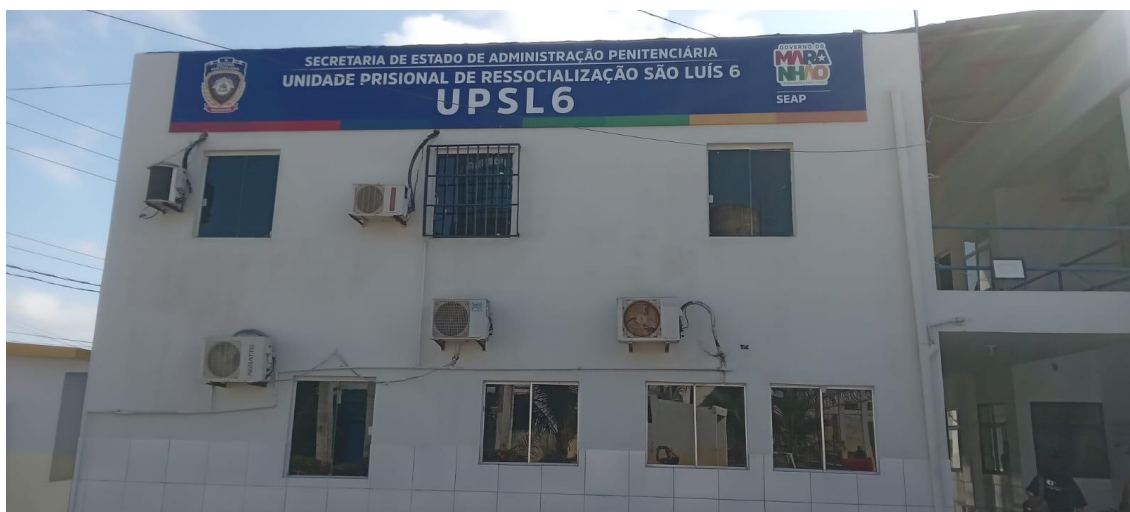
Figura 9 - Vista parcial do prédio administrativo da UPSL 6
