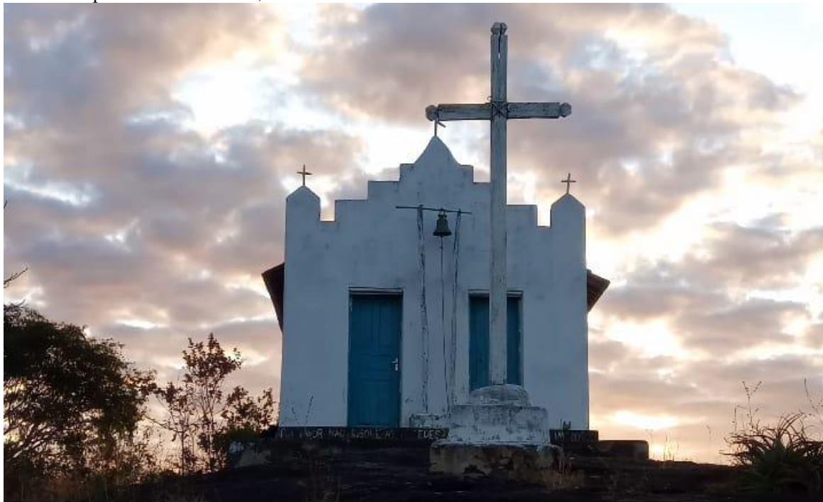
Foto 7 – Capela de São Sebastião, construída em 1962.
