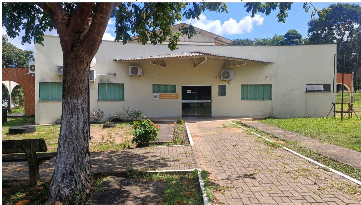
Figura 17 –Fachada da Clínica Veterinária Universitária da Universidade Federal do Norte do Tocantins (CVU/UFNT), Araguaína-TO, 2025.
