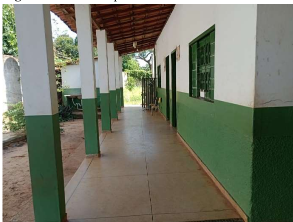
Figura 9: Corredor que da acesso aos banheiros e salas de aulas
