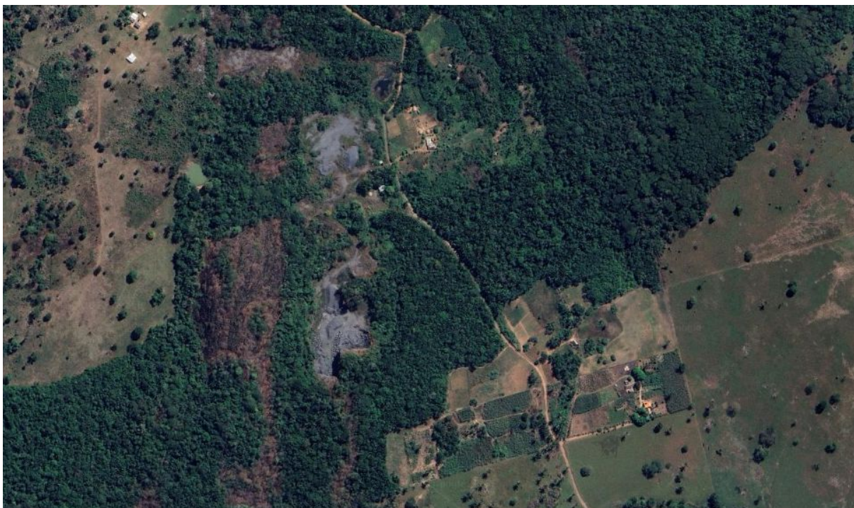
Figura 8- Área de mineração de brita abandonada
