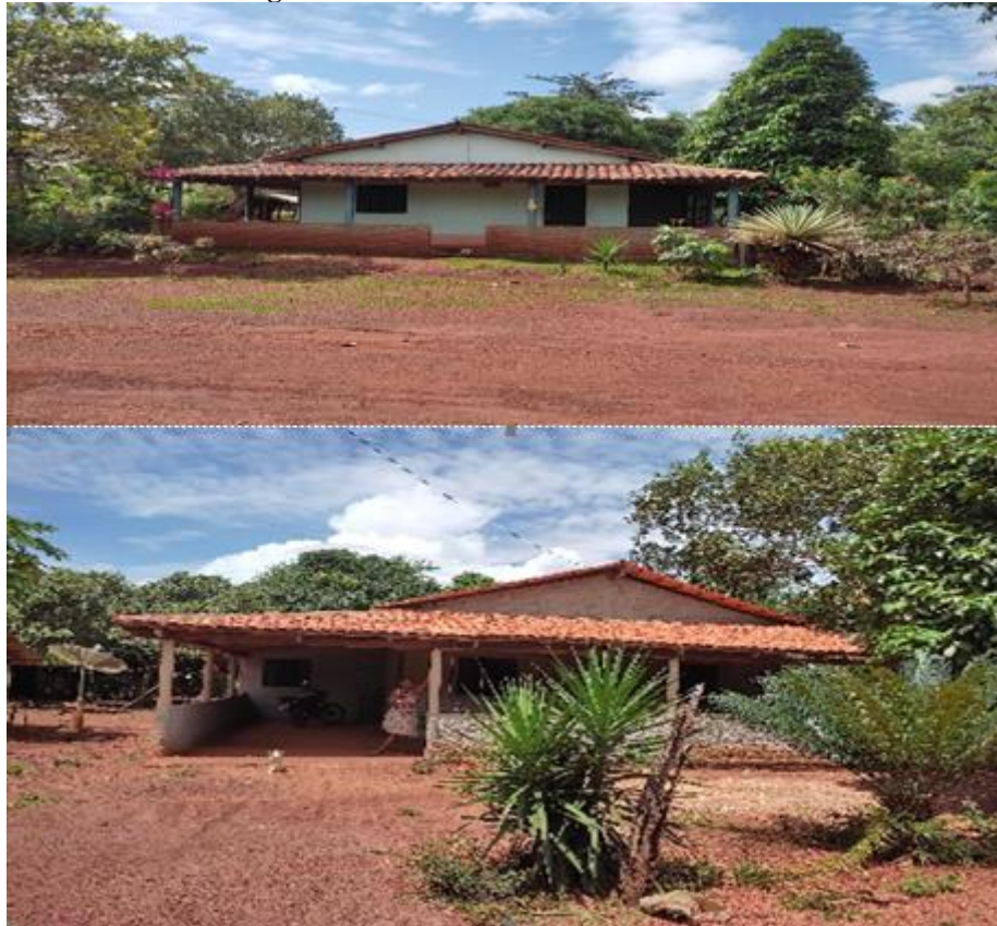
Figura 18 - Casas construídas de alvenaria
