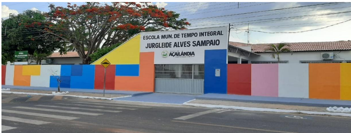
Figura 1—Escola Municipal de Ensino Fundamental Jurgleide Alves Sampaio
