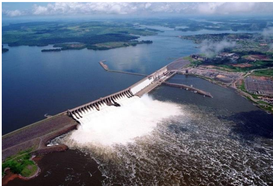
Figura 63 - Usina hidrelétrica de Tucuruí
