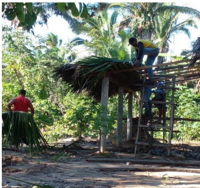
Figura 45 - Armação e cobertura da casa com palha do babaçu é uma das atividades realizada mais por homens
