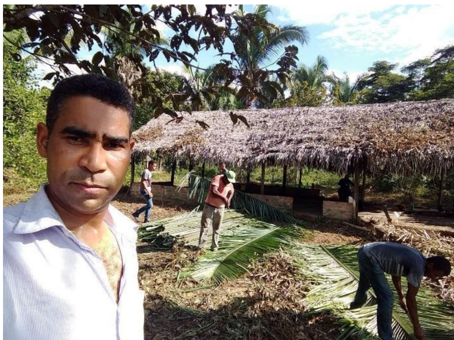
Figura 41 - Mutirão para cobertura do barracão da associação com palha do babaçu
