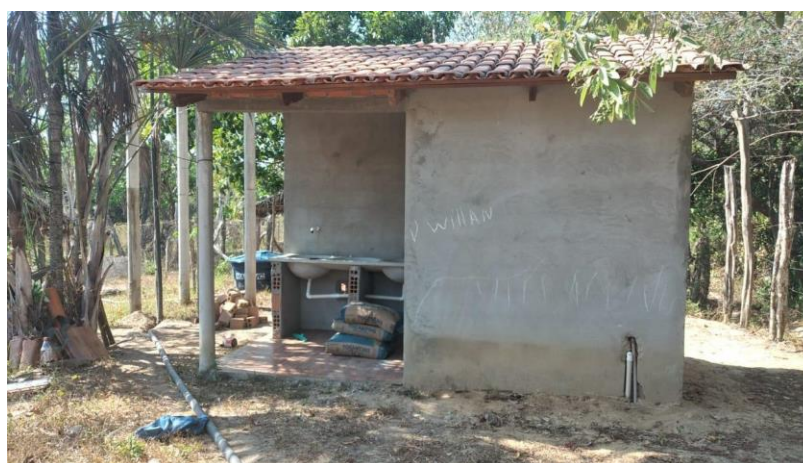
Figura 15 - Banheiro construído com área de serviço no quilombo
