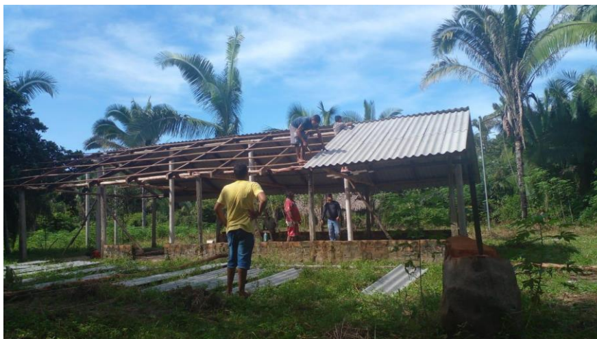
Figura 14 - Reforma do barracão da associação
