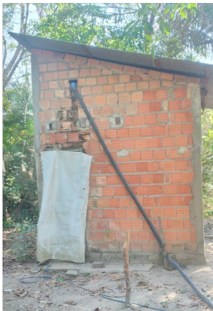
Figura 16 - Banheiro de tijolos construído afastado da residência
