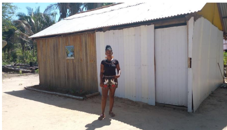
Figura 17 - Casa da Silvanei construída com material reaproveitado, pvc, telha e talo
