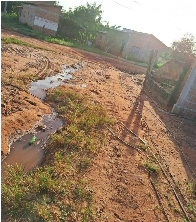
Figura 2 - vista de rua no Setor Deus É Fiel, onde é visível a exposição das encanações hidráulicas improvisadas, assim como as fiações das “gambiaras de eletricidade”.
