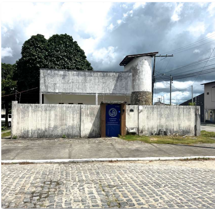
Figura 1 - Fachada do prédio da empresa JA Reprogen, município de Eunápolis, Bahia
