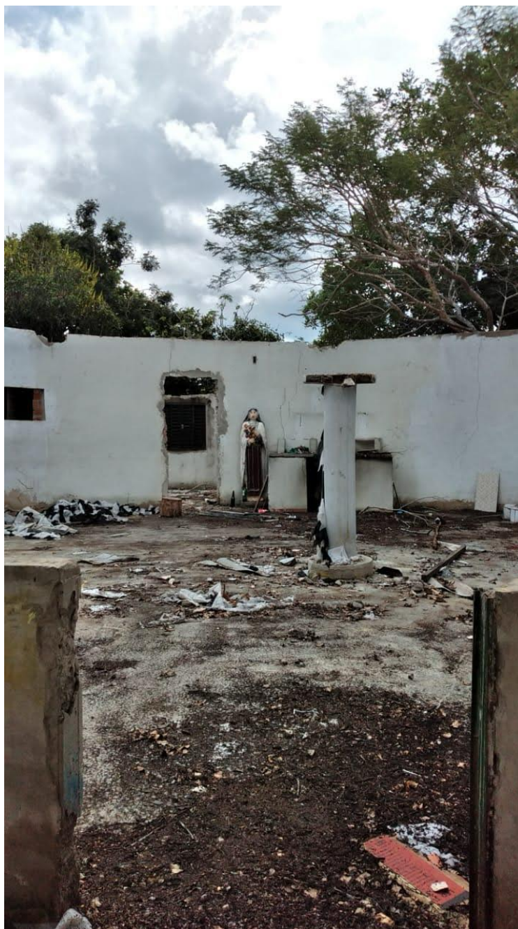
Figura 20 - Terreiro após a destruição
