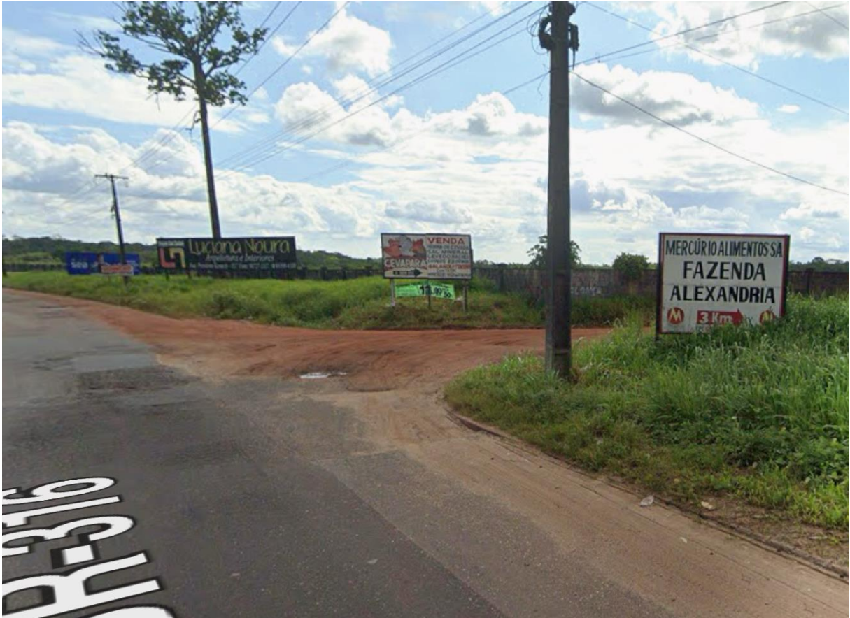
Figura 1 - Entrada para fazenda Alexandria – Santa Izabel do Pará – PA, 2024
