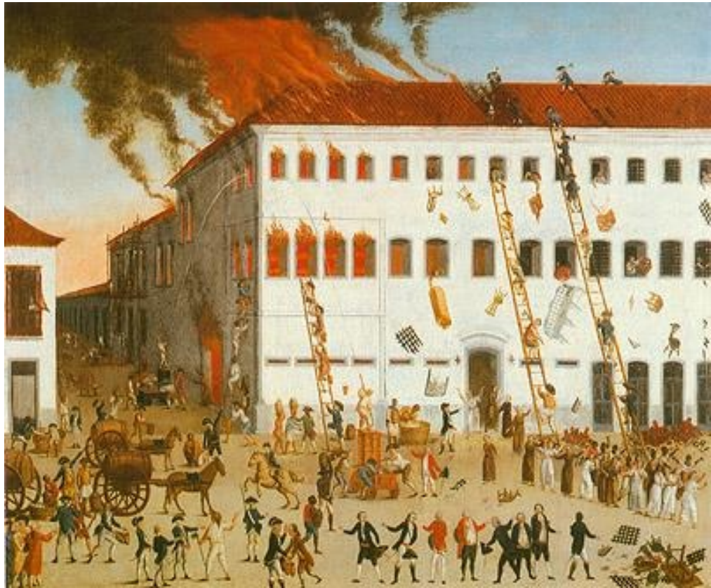
Imagem 01: Incêndio do Recolhimento de Nossa Senhora do Parto
