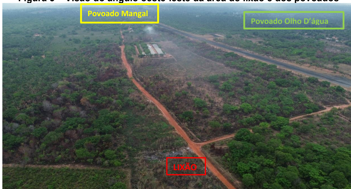
Figura 3 – Visão do ângulo oeste-leste da área do lixão e dos povoados
