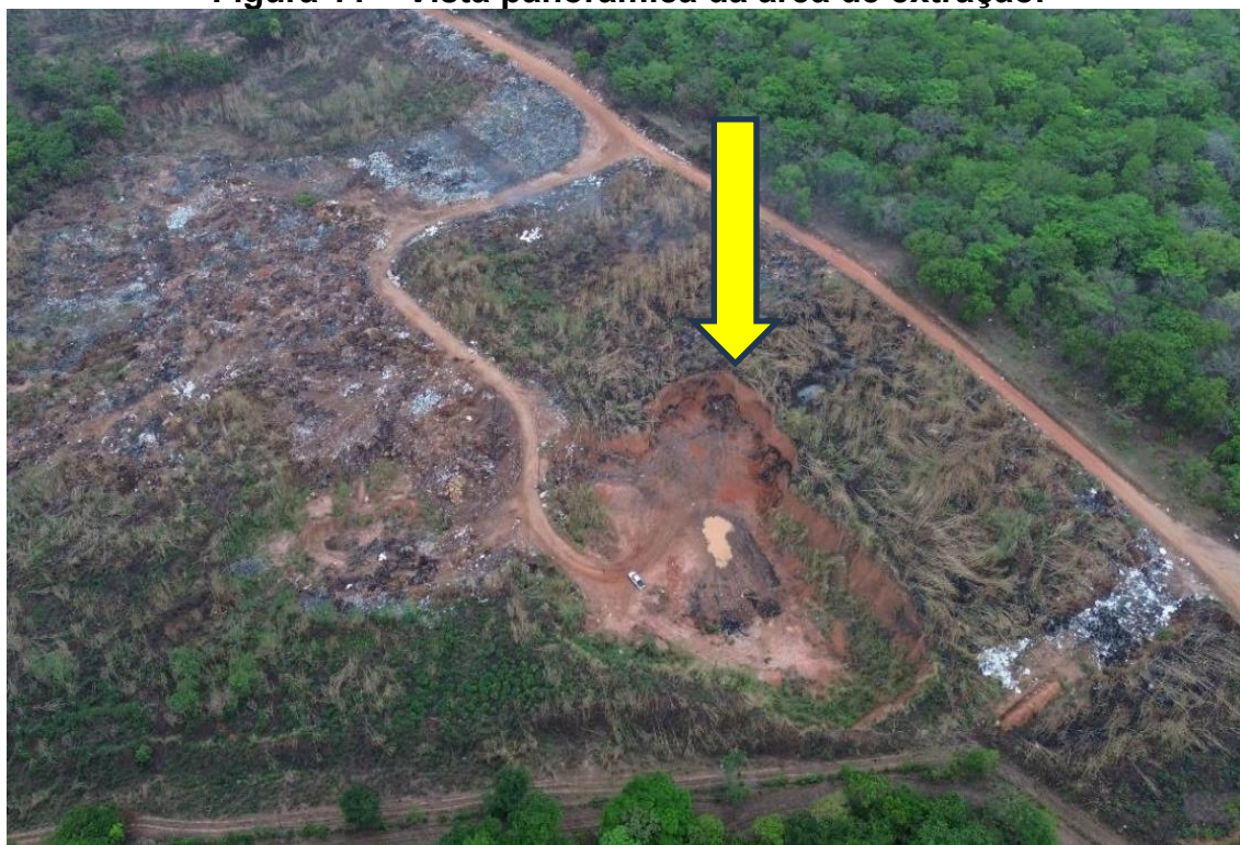
Figura 11 – Vista panorâmica da área de extração.
