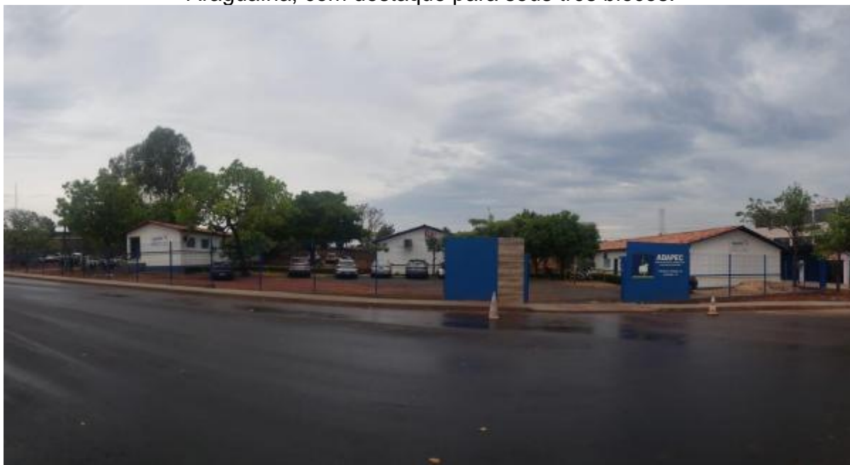
Figura 1 - Fachada da sede da Agência de Defesa Agropecuária do Tocantins em Araguaína, com destaque para seus três blocos.
