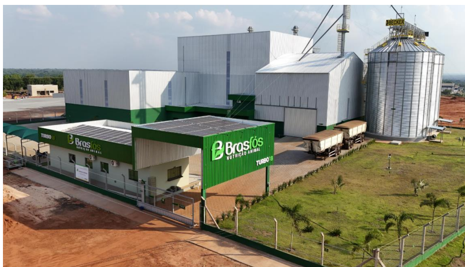
Figura 2. Unidade Industrial Brasfós em Araguaína-TO
