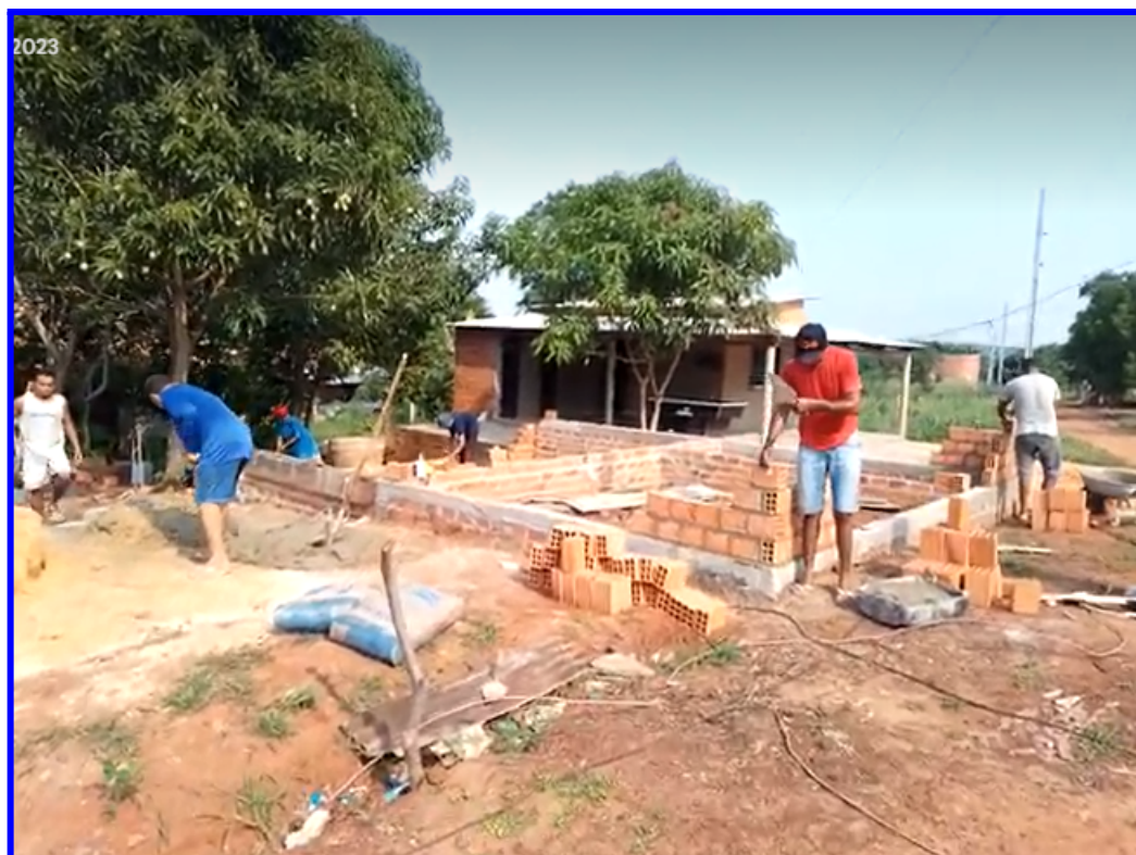
Figura 3: Mutirão para construção da casa da dona I. R. S., comunidade Jardim Deus é Fiel
