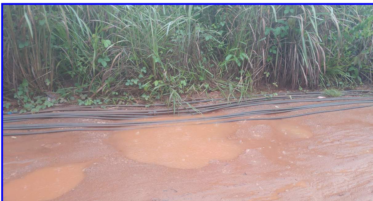
Figura 11: ligação clandestina de água, na comunidade Jardim Deus é Fiel
