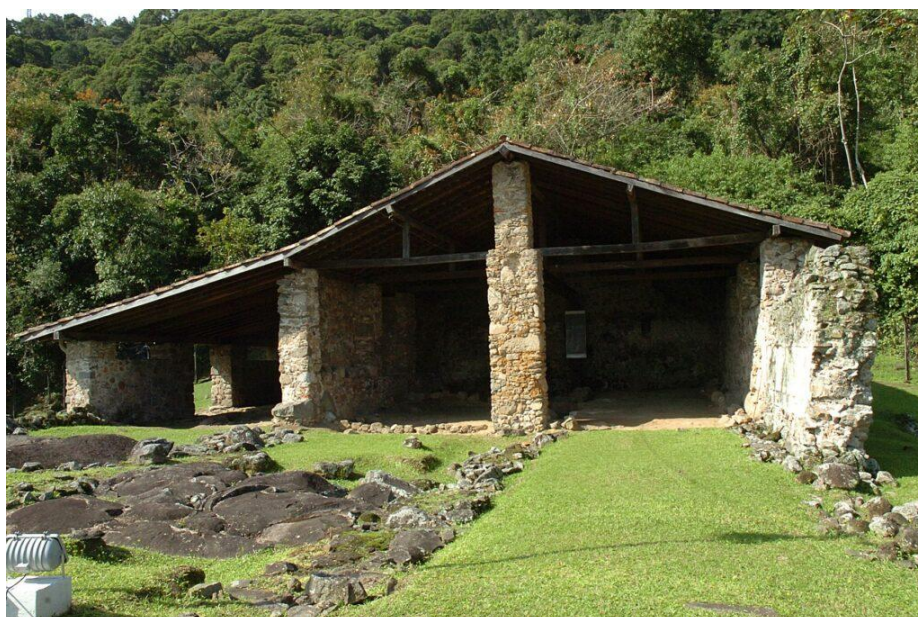
Figura 1 - Ruínas do Engenho de São Vicente dos Erasmos
